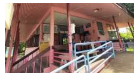
8. อาคารเรือนนอน 4 รัตนบุรี
